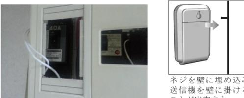
クランプのケーブルは、上の写真のように配電盤のカバーの窓から配線を這わすと便利です。通常、配電盤のカバーには、窓の枠を切り取ってスペースが調整出来るようになっています。この方法を利用すると、クランプを取り付けてもカバーの蓋を閉じて利用することが出来ます。配電盤が窓の無い、特殊な形状である場合は、カバーの蓋を閉じて利用できない場合があります。
